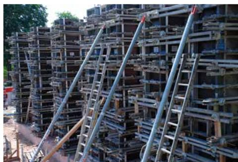
Coffrages renforcés pour bétonnage des colonnes
